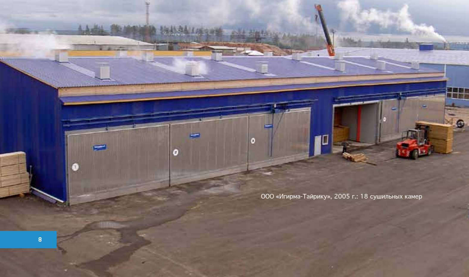
Сушильная камера 150 куб.м, загружаемая погрузчиком.
